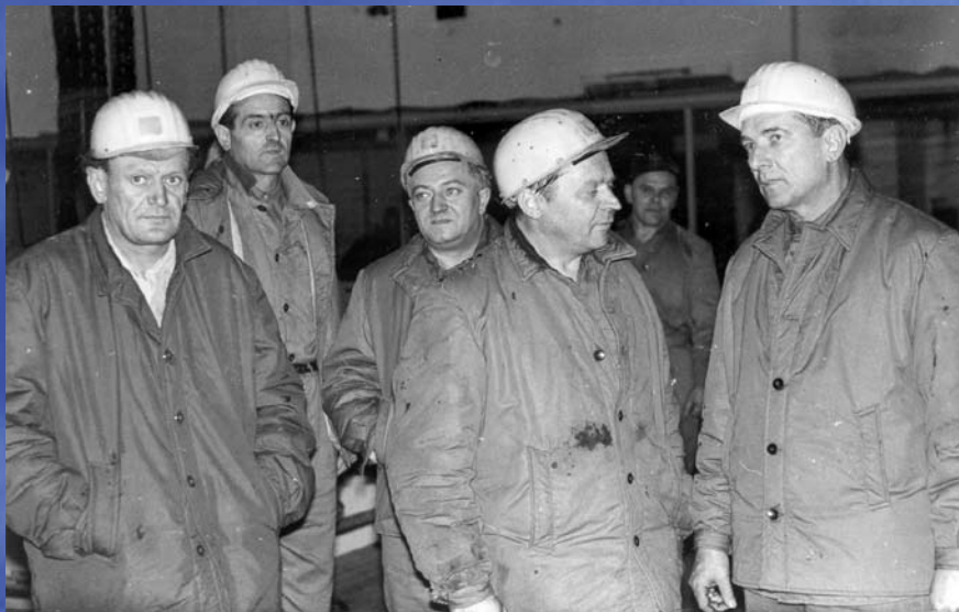
Боршодский угольный бассейн, Венгрия, 1972 г.
