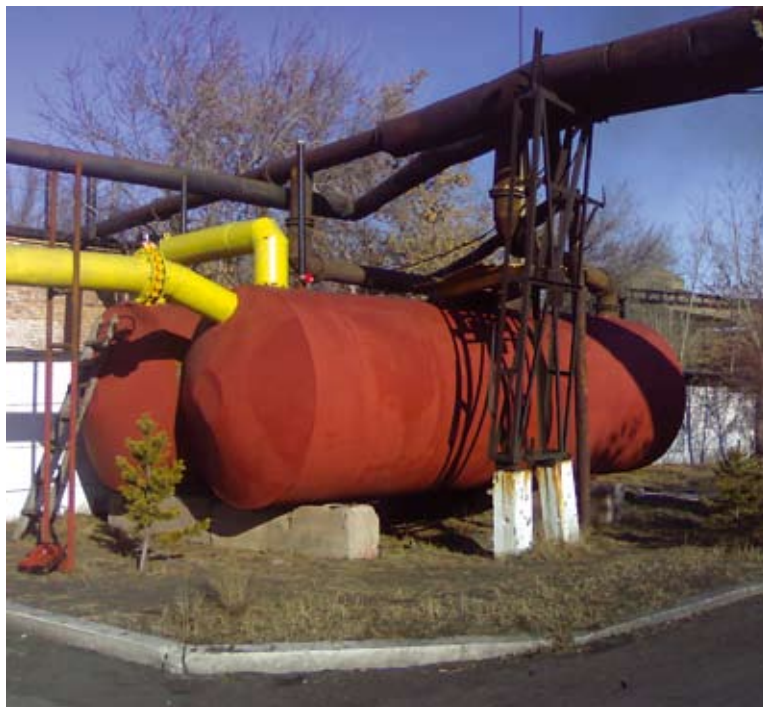
Рис. 6. Блочно-модульная установка МДРС-180 с дополнительными пыле-влажнотсекателями, установленная на промплощадке шахты им. Кузембаева
