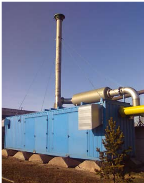
Рис. 6. Блочно-модульная установка МДРС-180 с дополнительными пыле-влажнотсекателями, установленная на промплощадке шахты им. Кузембаева
