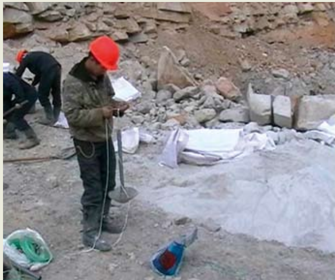
Рис. 3. Установка подвешенного скважинного затвора
