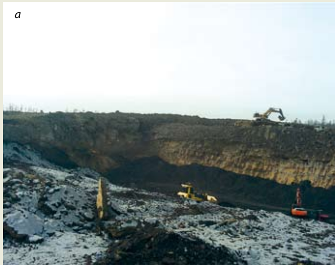
Рис. 5. Положение забоя блока: а – до взрыва; б - после взрыва
