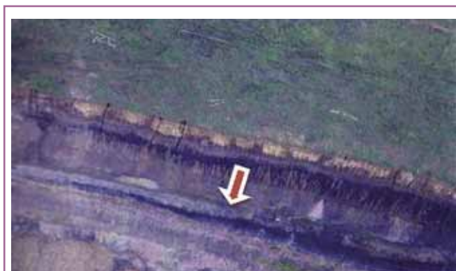
Рис. 3. Деформации уступов верхних горизонтов (участок № 6, оползень, гор. +200 – +186 м, р.л. 36 +12 м – р.л. 36 +652 м)
