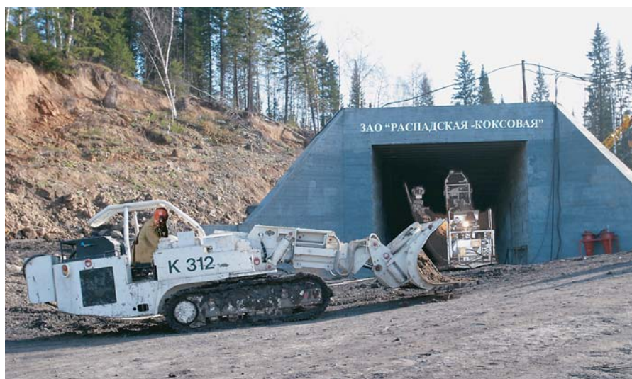
Наклонный ствол строящейся шахты «Распадская-Коксовая»
