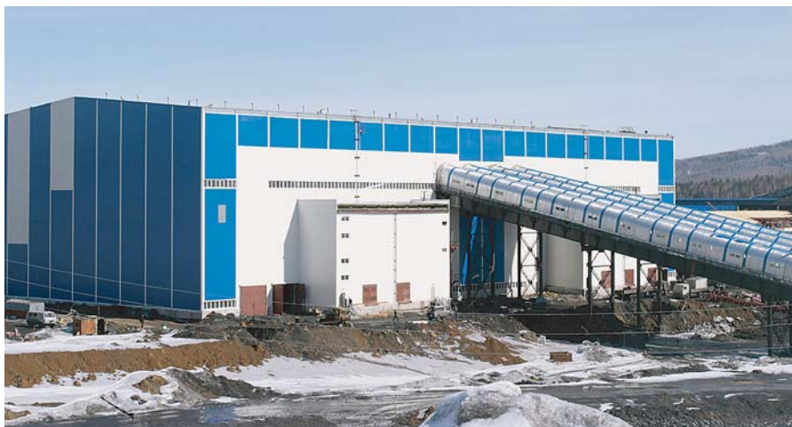
Строительство обогатительной фабрики «Распадская»
