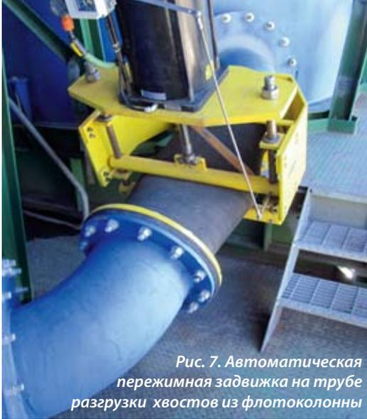
Рис. 7. Автоматическая пережимная задвижка на трубе разгрузки хвостов из флотоколонны
