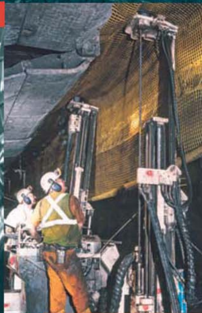
Лавные анкероустановщики Sandvik повышают безопасность работ и сокращают сроки подготовки демонтажной камеры
