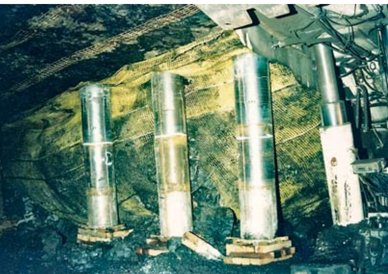
Рис. 6. Применение сетки HUESKER для крепления кровли в демонтажной камере
