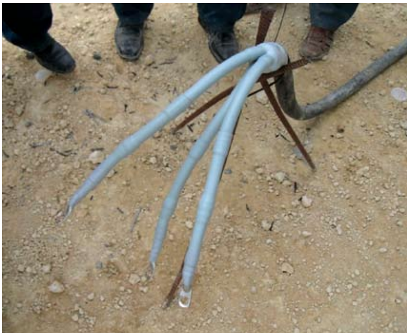
Рис. 2. Концевая муфта серии 92-EB CS в смонтированном состоянии
