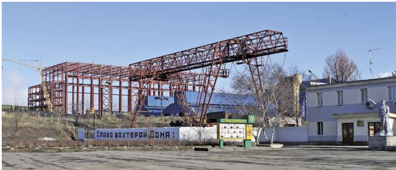
Рис. 2. На промплощадке действующей шахты «Садкинская» строится новая обогатительная фабрика
