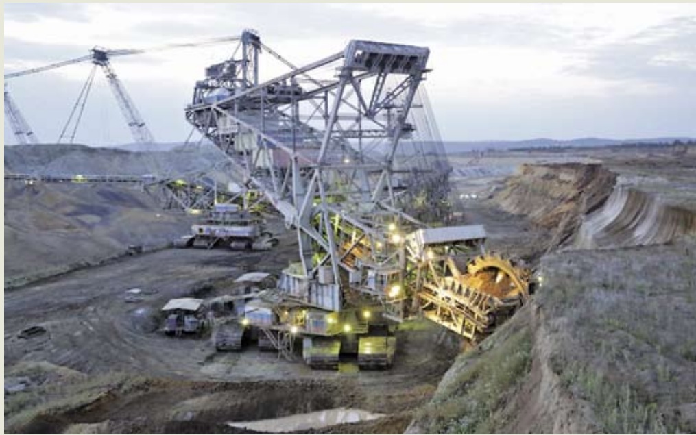
Транспортно-отвальный вскрышной комплекс SRs (K) -4000 на разрезе «Назаровский»
