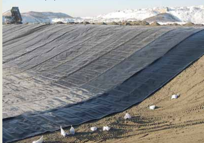
Рис. 11. Место строительства сооружений по очистке карьерных вод
