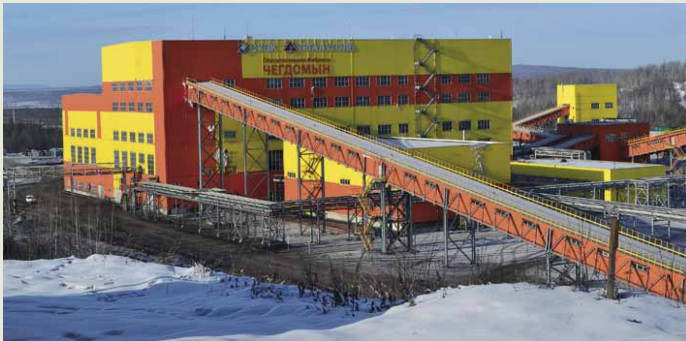
Рис. 21. Хабаровский край. АО «Ургалуголь». Обогащительная фабрика «Чегдомын». В марте 2017 г. коллективом фабрики установлен собственный рекорд – впервые со дня ввода предприятия в эксплуатацию переработано 442,5 тыс. т угля за месяц
