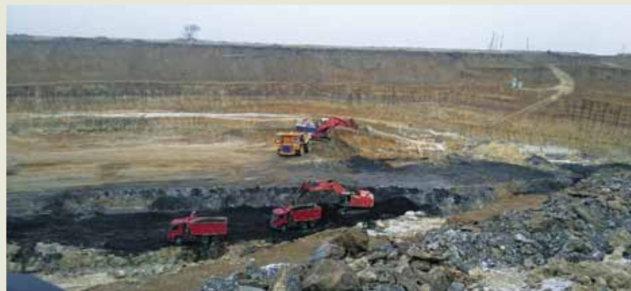
Рис. 22. Приморский край. Новый разрез «Некковый». В декабре 2017 г. добыта первая тонна угля на участке «Некковый» Липовецкого каменноугольного месторождения
