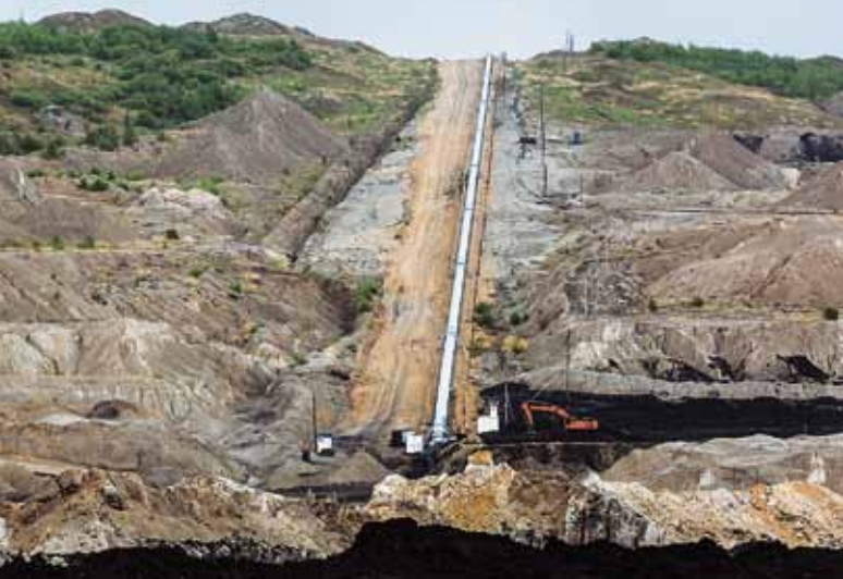
Рис. 13. Конвейерный комплекс по доставке угля на технологический комплекс поверхности РУ «Новошахтинское»
