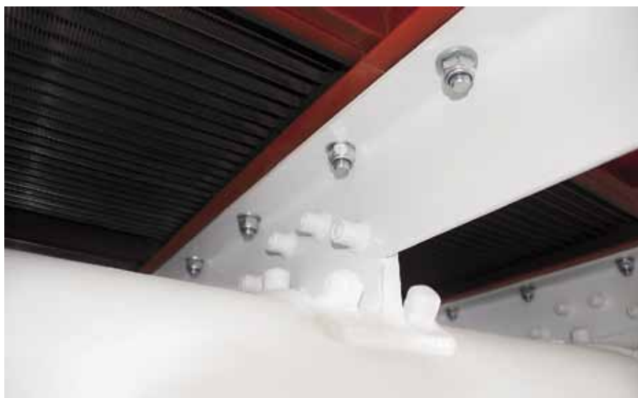
Рис. 2. Соединение продольной балки и связь-балки
