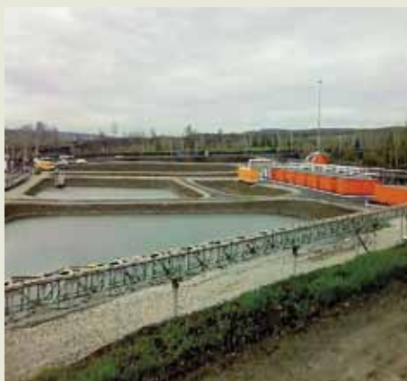
Рис. 16. Кузбасс. Шахта «Талдинская-Западная – 1». Очистные сооружения шахтных вод
