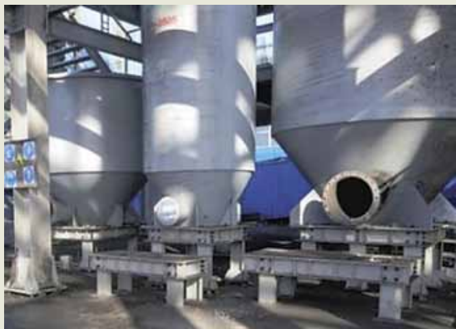
Рис. 25. Технология монтажа оборудования с последующим устройством фундаментов. Оборудование установлено на легкие металлоконструкции и подготовлено к последующей заливке фундаментов
