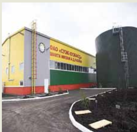
Рис. 15. Кузбасс. Шахта им. А.Д. Рубана, участок «Магистральный». Очистные сооружения шахтных вод
