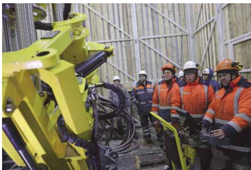
Для бурения скважин большого диаметра горняки шахты «Ерунаковская-VIII» применяют станок Robbins Epiroc
