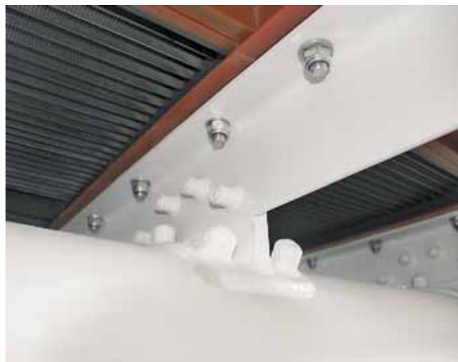
Рис. 2. Соединение продольной балки и связь-балки
