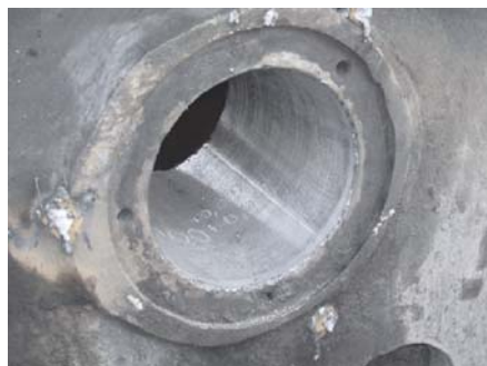
Восстановленное отверстие редуктора
