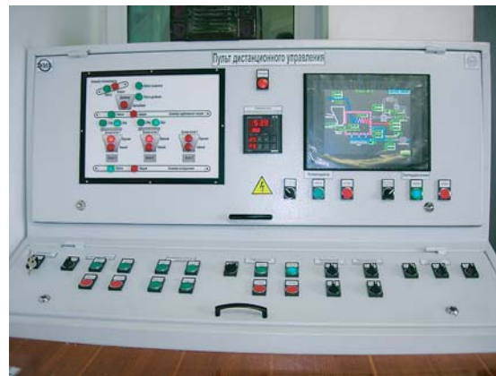
Рис. 3. Панель поста управления механизмами котла
