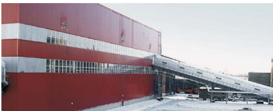
ОФ «Листвянская» покрытие ЦВЭС+ПОЛИТОН-УР
