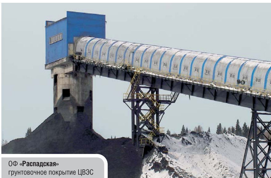
ОФ «Междуреченская» грунтовочное покрытие ЦВЭС
