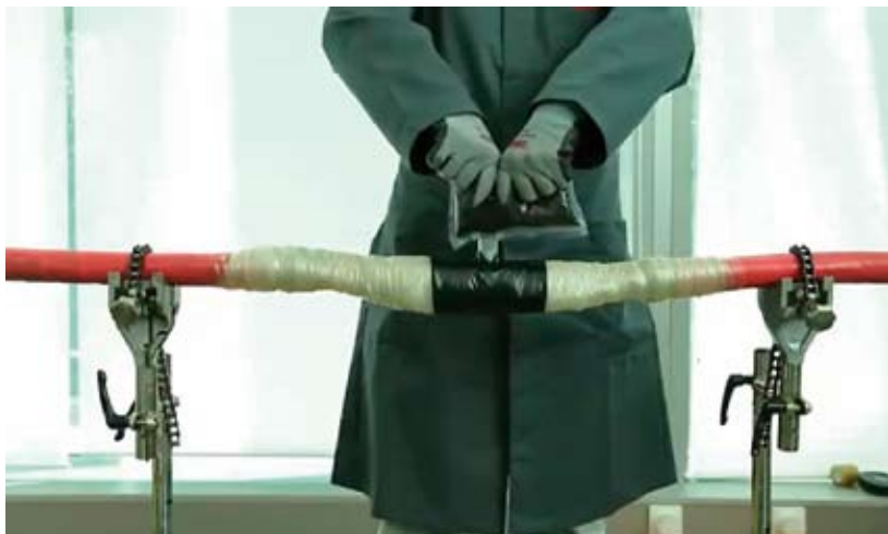
Рис. 3. Монтаж муфты ЗМ 92-А 615
