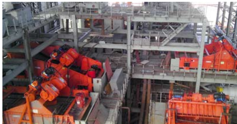
Этажерки модульного типа главного корпуса углеобогащительной фабрики «Эльгинская» (на этапе строительства)
