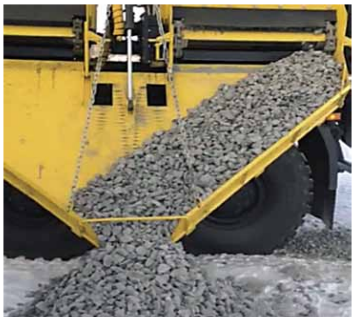
Рис. 6. Забойка скважин из бункеров Fig. 6. Tamping holes from bunkers
