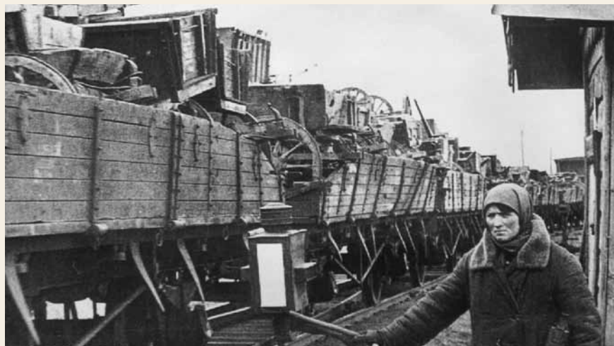
Эвакуация оборудования на восток страны
