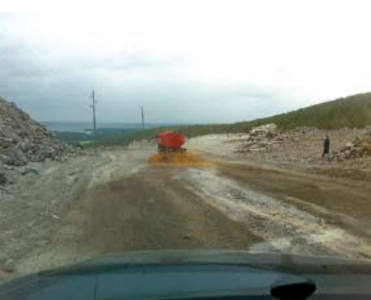
Обработка дорог пылесвязывающим средством РНХ-1021
