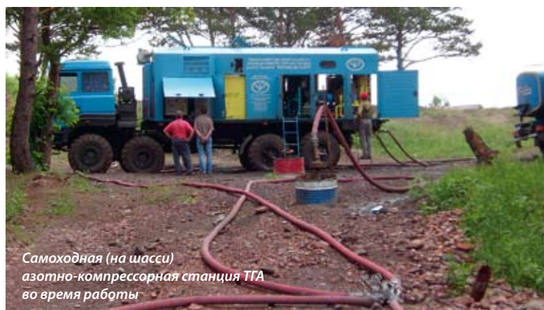
Сервисная служба ТEGАС на объекте
