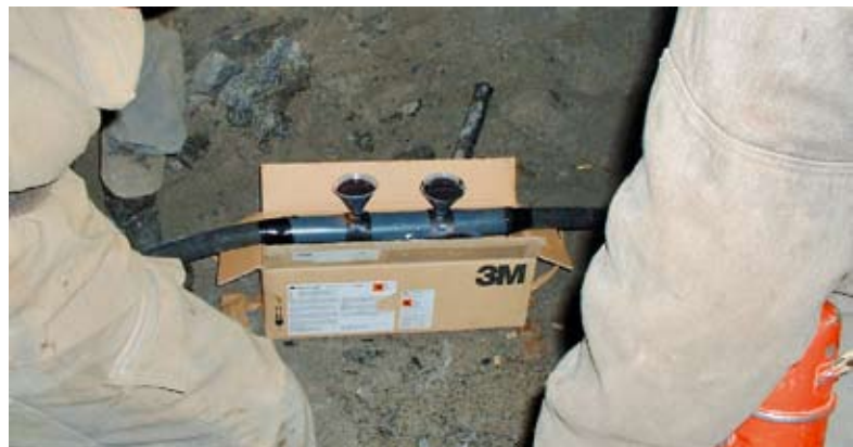
Рис. 1. Муфта серии 92-AV 170
