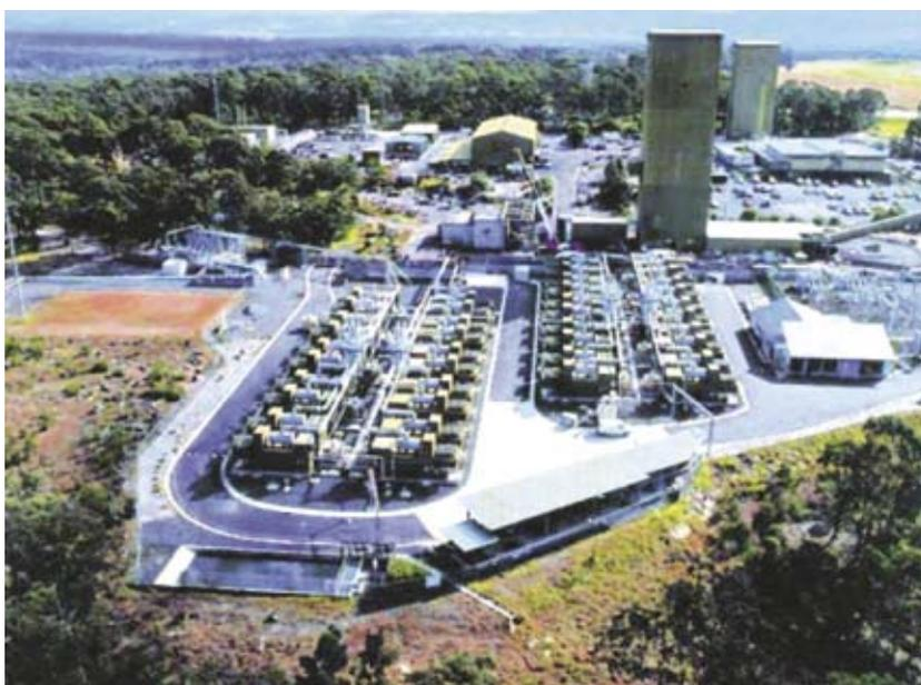
Рис. 2. Теплоэлектростанция на базе МиниТЭС, работающая на метане средств дегазации (94 МВт); BHP Billiton's Appin & Tower Coal Mines, Новый Южный Уэльс, Австралия
