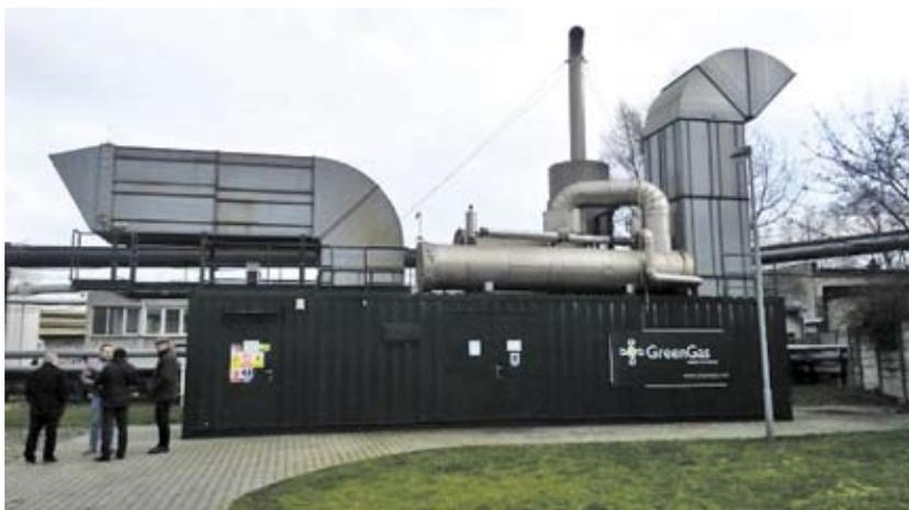
Рис. 3. Теплоэлектростанция на базе МиниТЭС, работающая на метане средств дегазации (28,1 МВт); шахта ГринГаз ДПБ, Чехия
