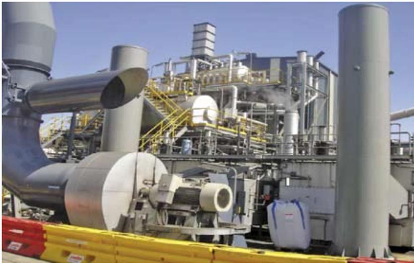
Рис. 4. Электростанция, работающая на метане вентиляционной струи ( $CH_4 = 0,9\%$ ), мощность 5 МВт; шахта West Cliff Colliery BHP Billiton, Австралия
