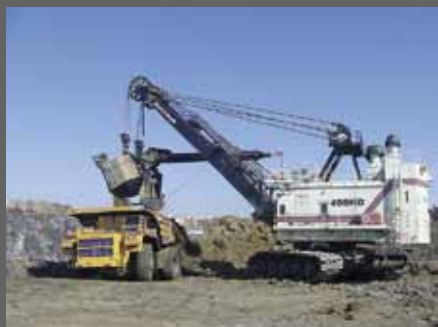
Монтаж экскаваторов отечественного и импортного производства
