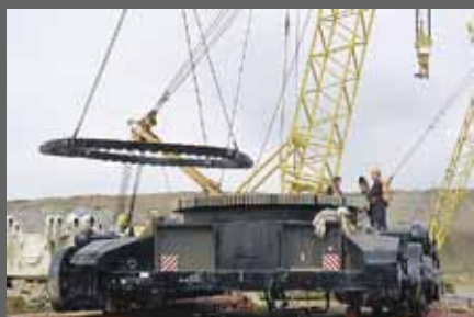
Монтаж экскаваторов отечественного и импортного производства
