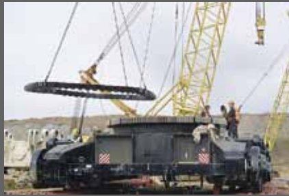
Монтаж экскаваторов отечественного и импортного производства
