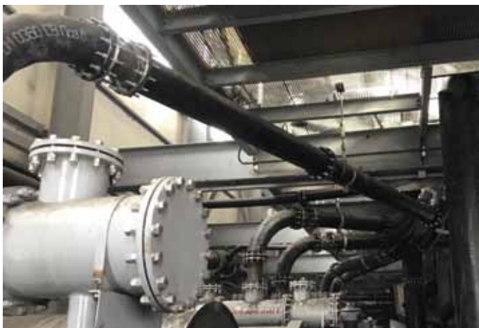
Стальная труба с базальтовой вставкой (EUTIT s.r.o, Чехия)
