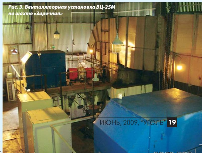
Рис. 3. Вентиляторная установка ВЦ-25М на шахте «Заречная»
