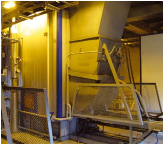
Рис. 1. Котел водогрейный KBm-2,5-K-95(115)
