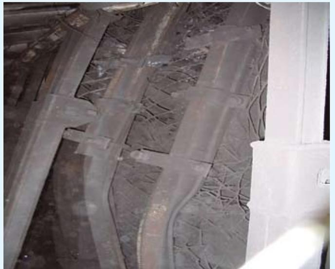
Рис. 1. Состояние конвейерного промежуточного штрека 49к<sub>10</sub>-3 шахты им. Костенко в зоне влияния очистных работ: а — деформация верхняка; б — деформация стоек
