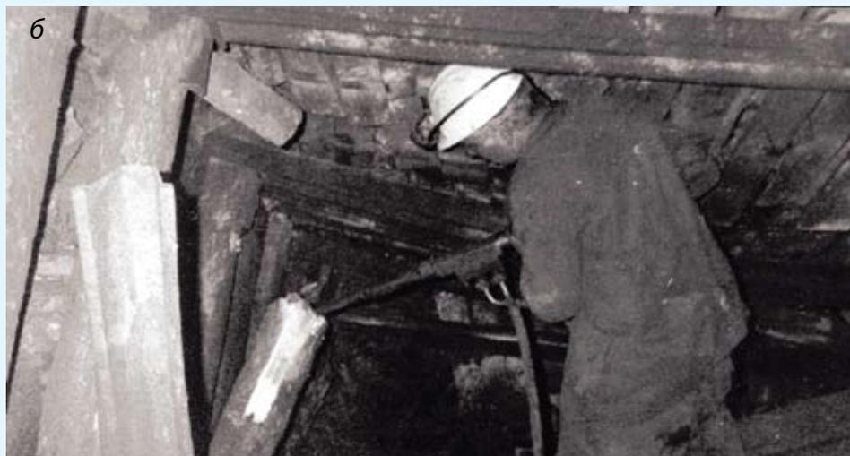
Рис. 1. Применение гидравлических ручных молотков в горном производстве: а — при оборке кровли в лаве; б — при оформлении ниш
