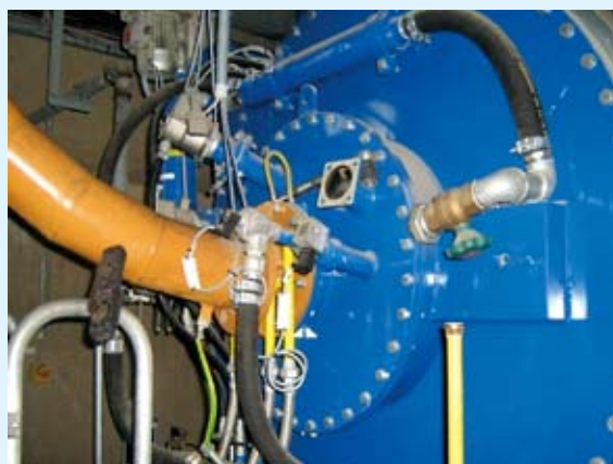
Рис. 3. Генератор горячих газов, работающий на угольной пыли
