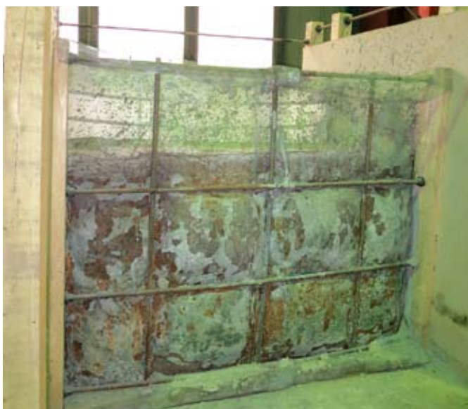
Процесс заливки перегородки в опалубку из специальной мелкоячеистой сетки с дополнительным арматурным каркасом
