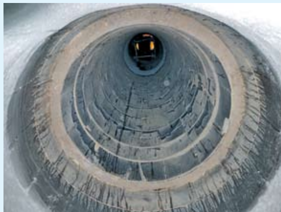
Рис. 2. Противоабразивная защита корпуса вертикальной трубы-сушилки
