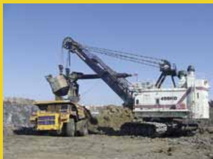
Монтаж экскаваторов отечественного и импортного производства
