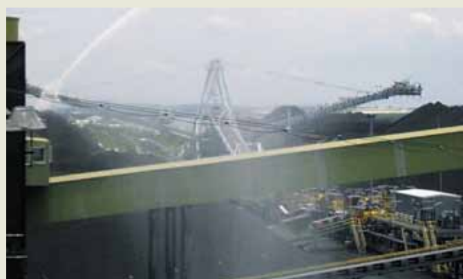
Рис. 8. На территории терминала вдоль угольных складов установлены водяные опрыскиватели*, число которых равно 177**
