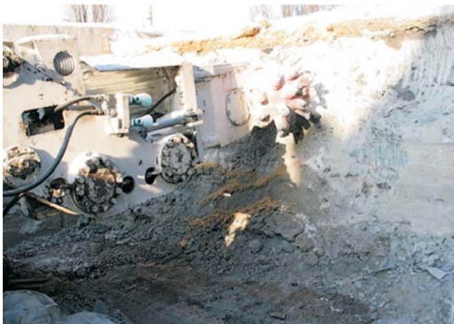
Рис. 4. Проходческий комбайн КПЛ на пороцементном блоке
