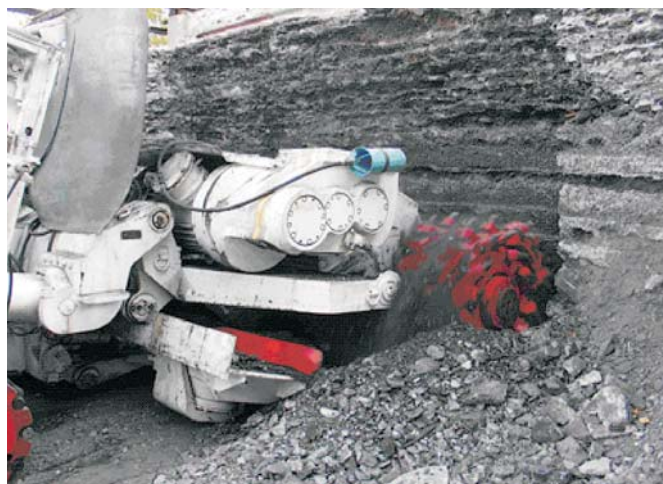
Рис. 6. Проходческо-анкероувальный комплекс КПА на углепородоцементном блоке
