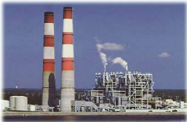
Энерготехнологический комплекс по глубокой переработке угля
