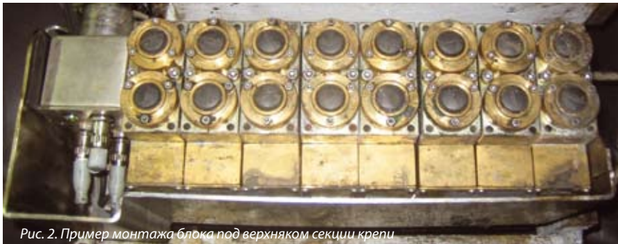
Рис. 2. Пример монтажа блока под верхняком секции крепи
