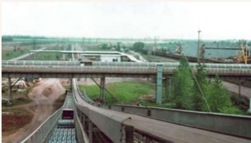
Трасса канатно-ленточного конвейера (КЛК) с подъемом к бункеру загрузки обогатительной фабрики
