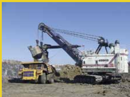
Монтаж экскаваторов отечественного и импортного производства
