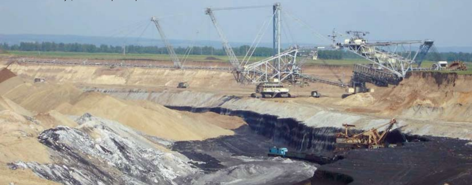
Рис. 2. Осуществление вскрышных работ комплексом
