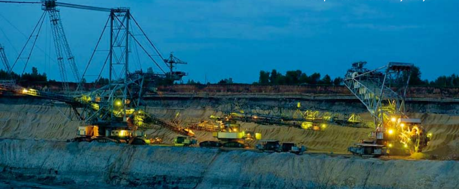
Рис. 3. Работа вскрышного комплекса в ночную смену
