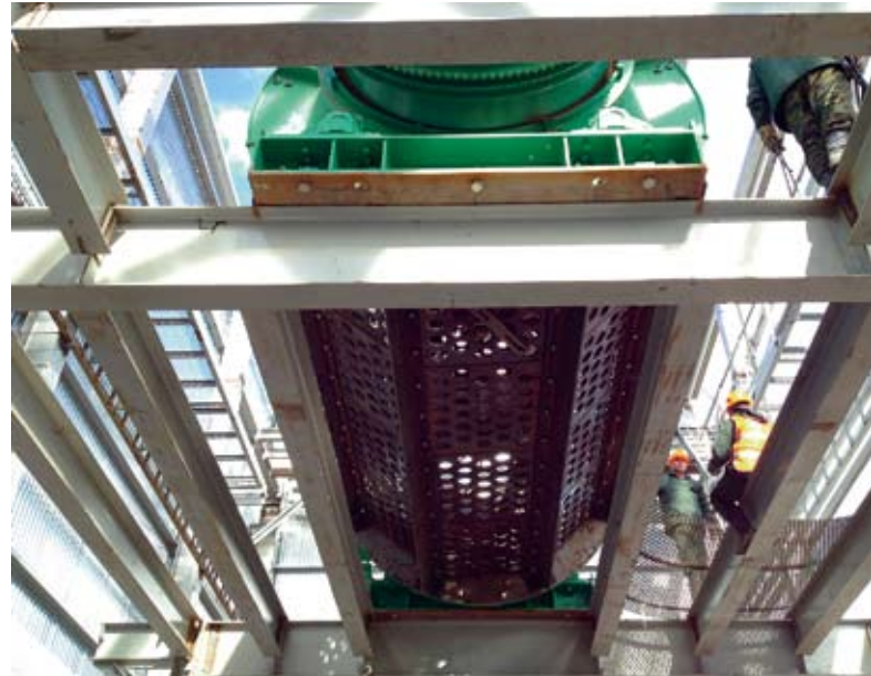
Рис. 3. Монтаж дробилки на углеобогатительной фабрике в Якутии
