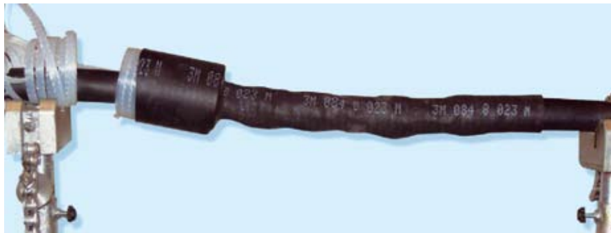
Рис. 3. Монтаж трубки холодной усадки в составе муфты ЗМ серии 3123
