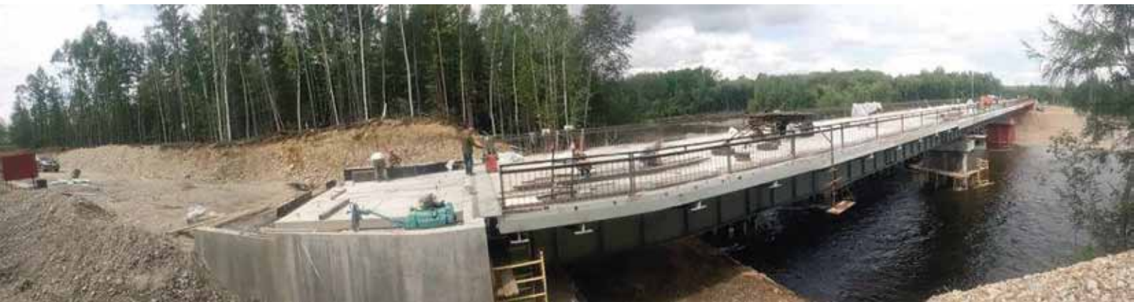
АО «Ургалуголь». Разрез «Правобережный». Завершается строительство автомобильного моста через реку Ургал
