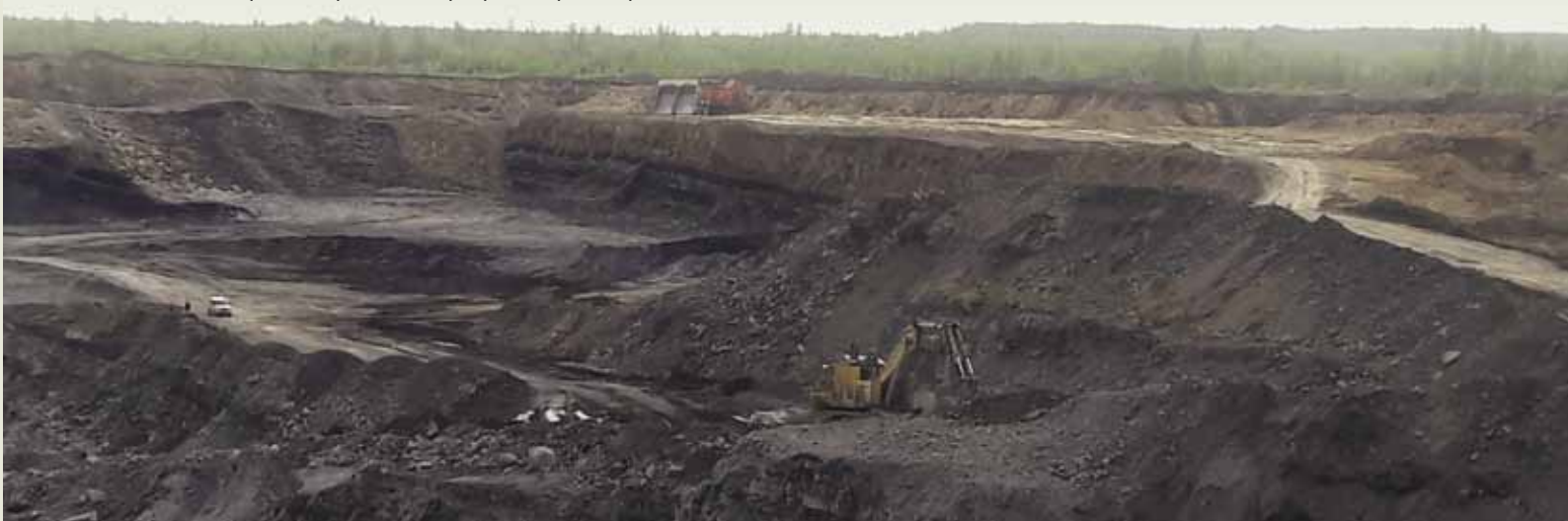
Рис. 5. Панорама строящегося разреза «Правобережный»
