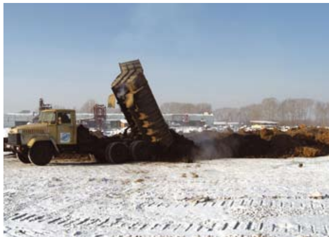
Рис. 7. Выемка золошлакового материала на «Красноярской ГРЭС-2» (слева); отсыпка верхнего рекультивационного слоя на поверхность сформированного «сухого» отвала (справа), февраль 2011 г.
