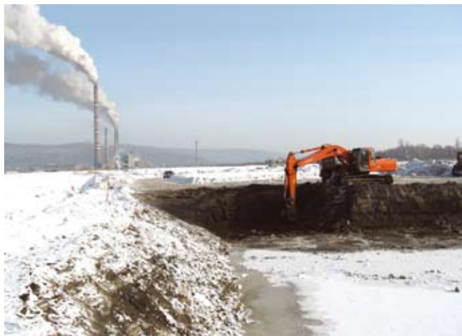
Рис. 7. Выемка золошлакового материала на «Красноярской ГРЭС-2» (слева); отсыпка верхнего рекультивационного слоя на поверхность сформированного «сухого» отвала (справа), февраль 2011 г.
