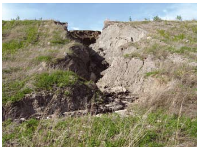
Рис. 6. Объекты водной эрозии — овраги: слева — откос внутреннего отвала; справа — откос внешнего отвала «Западный»
