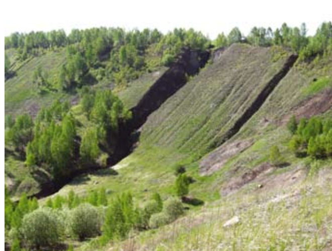
Рис. 6. Объекты водной эрозии — овраги: слева — откос внутреннего отвала; справа — откос внешнего отвала «Западный»
