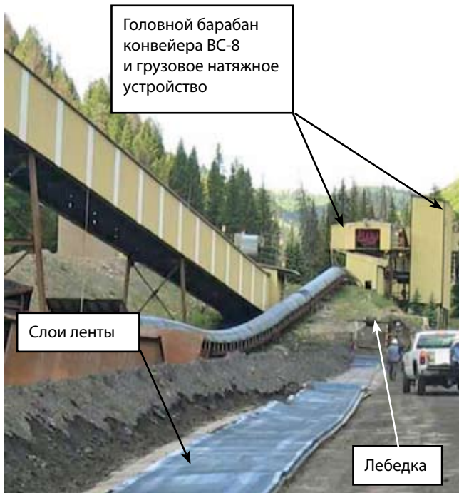
Рис. 7. Соединение и укладка ленты штабелями с помощью лебедки (слева) и установленные компенсирующие цилиндры в местах сгиба ленты (справа)
