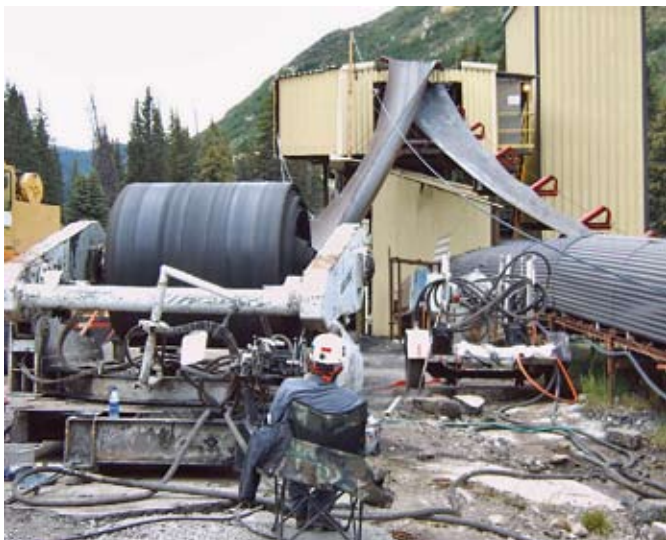
Рис. 9. Затягивание новой ленты в конвейерную установку
