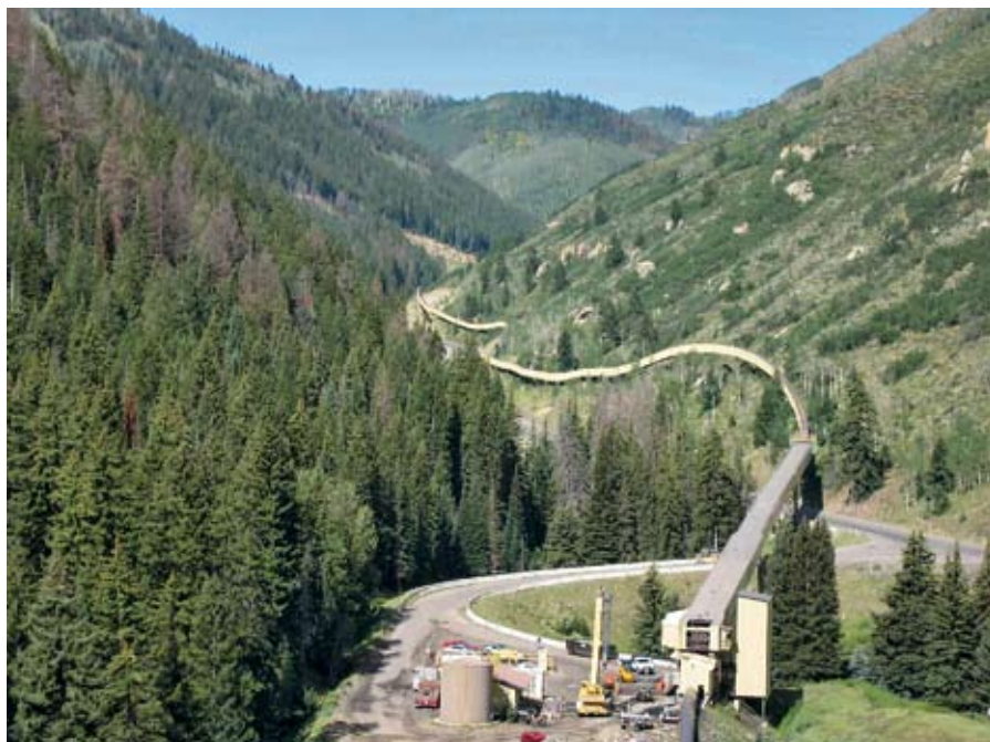
Рис. 1. Трубчатый конвейер со стороны разгрузочного головного барабана (слева) и устройства загрузки (справа)
