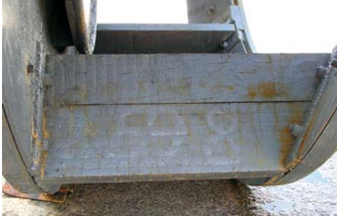
Рис. 3. Вентиляторная мельница – композитные плиты
