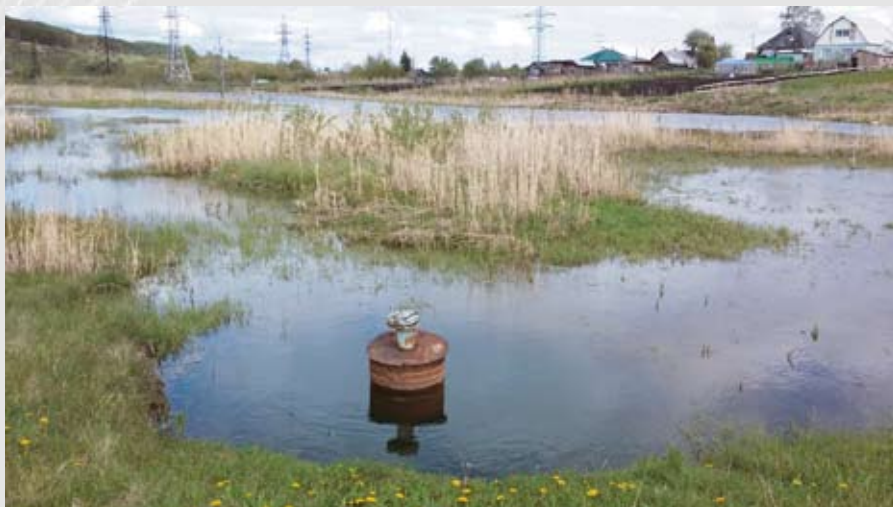
Рис. 1. Заболачивание территории в районе самоизливающих скважин на горном отводе ликвидируемой шахты «Ягуновская»
