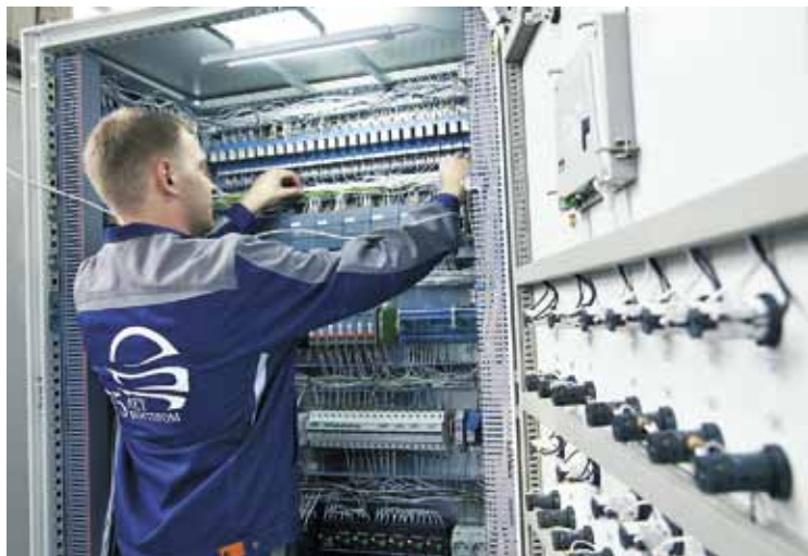
Рис. 3. Сборка шкафа управления
