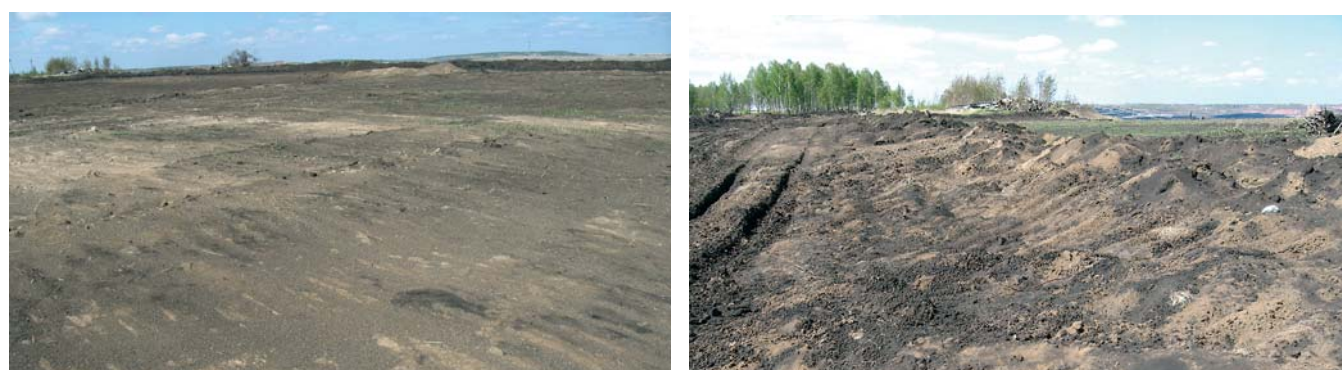
Рис. 6. Фрагмент поверхности верхнего вскрышного уступа, созданной в ходе выполнения работ по технической рекультивации: слева полоса снятия ПСП бульдозером — ВП. Б.; справа — основание отгруженного бурта ПСП — ВП. Э. экскаватором ЭКГ-6,3у (угольный разрез «Бородинский», май 2007 г.)
