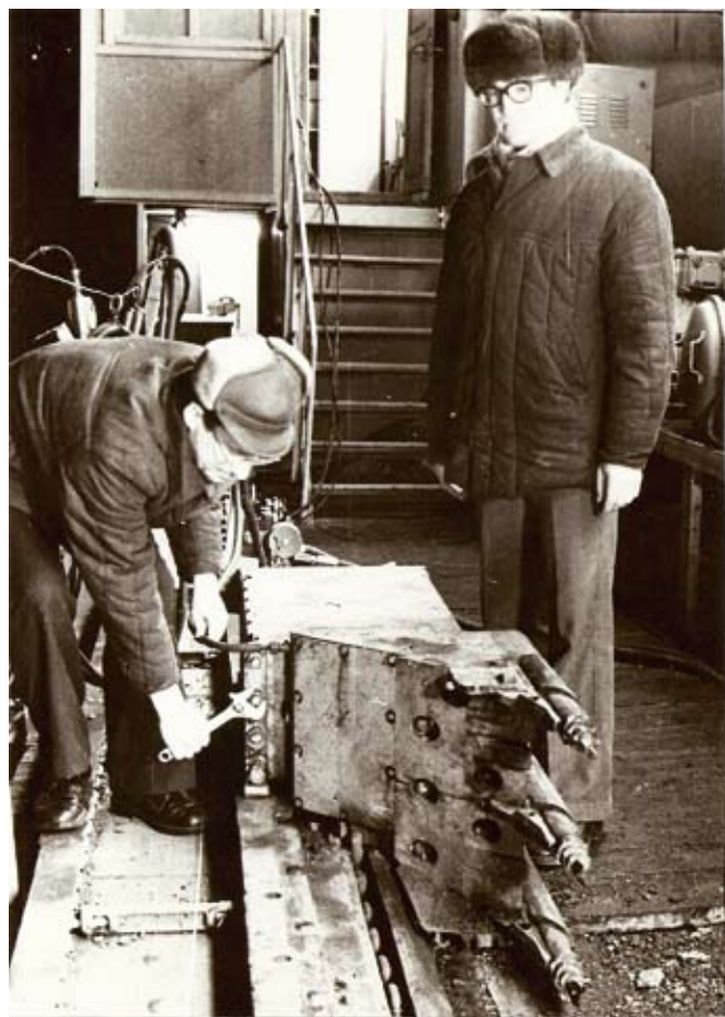
Рис. 2. Экспериментальный образец комбайна КБВ на стенде с угле-цементным блоком
