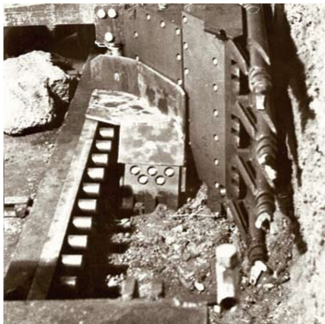
Рис. 3. Шахтные испытания комбайна КБВ с бесцепной системой подачи
