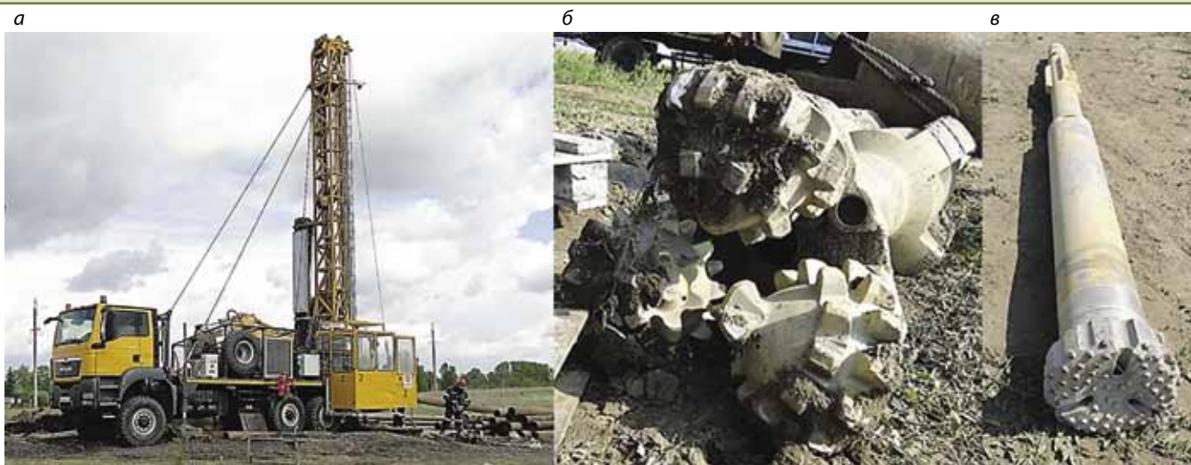
Рис. 1. Буровое оборудование для бурения глубоких дегазационных скважин с поверхности Fig. 1. Drilling equipment for drilling deep degassing wells from the surface
