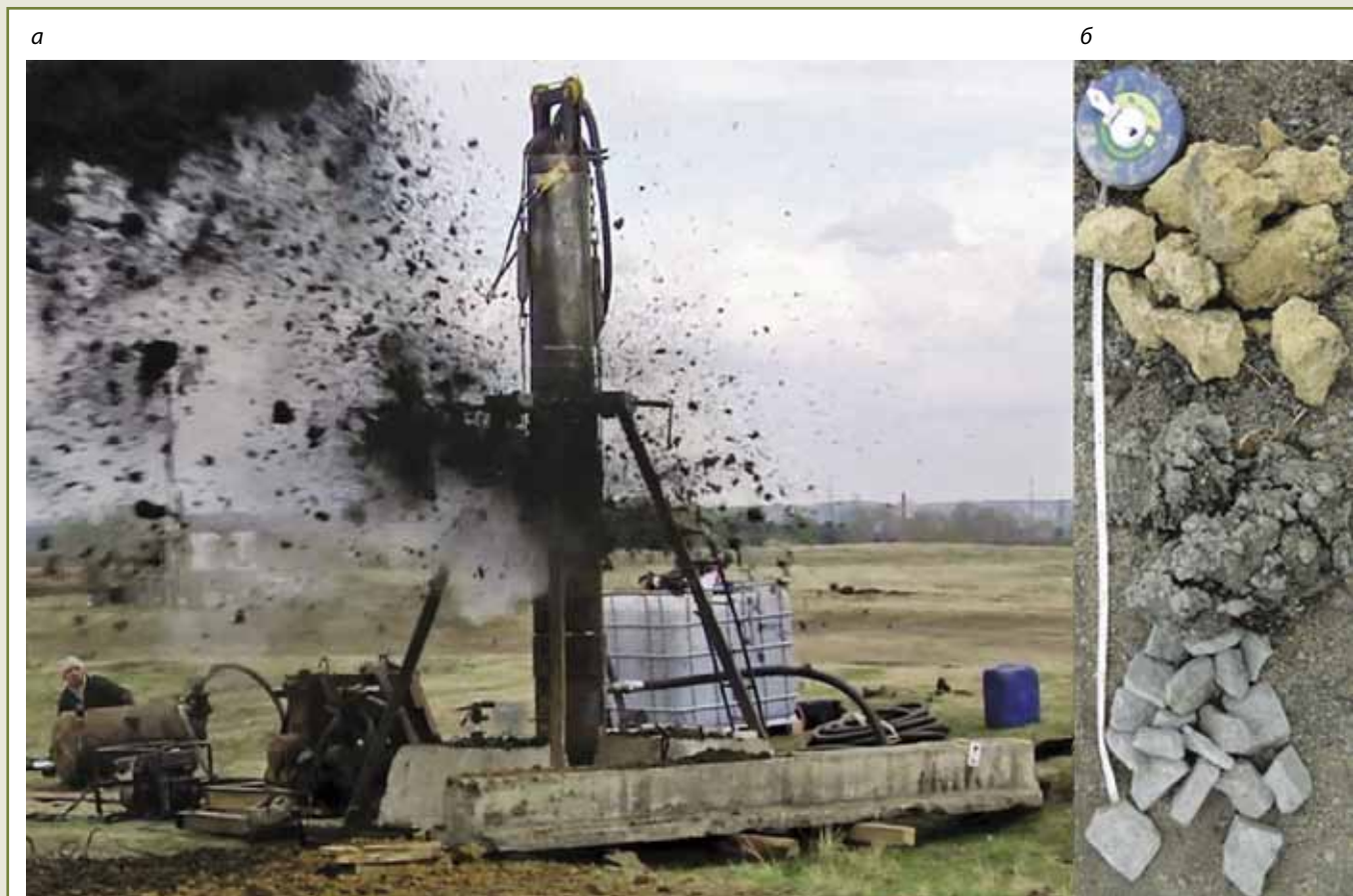
Рис. 5. Виброударное бурение скважины: а – порционное удаление грунта в процессе прохождения скважины; б – эволюция пород при бурении
