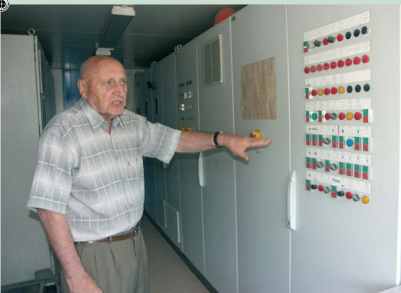
В комплекс второй стадии дробления встроены два процессора, которые обрабатывают поступающую информацию о работе отдельных узлов завода и управляют процессами в соответствии с заложенным алгоритмом.
