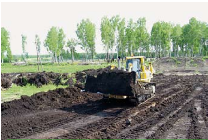
Рис. 1. Бульдозер Сomatsu D-155A на полигоне снятия ПСП (начальный этап горнотехнической рекультивации земель, разрез «Бородинский», июнь 2009 г.)
